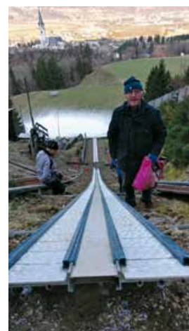
Martin Wiegele bei der Keramikspurverlegung bei der Sprungschanze
