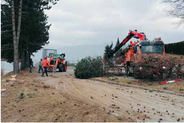
Das Arbeitsteam beim Fällen der alten Bäume vor der VS.
