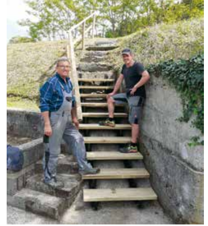
Die Wirtschaftshofmitarbeiter beim frisch sanierten Stiegenaufgang.
