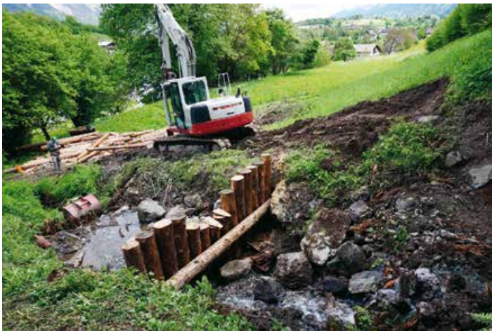
Baggararbeiten beim Göriacher Kirchenbach
