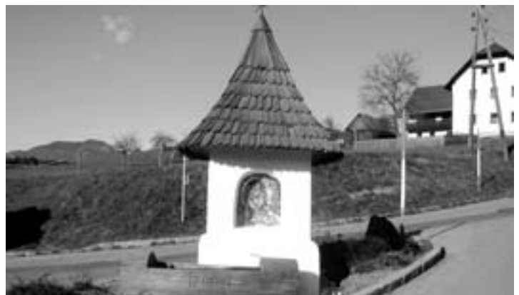
Der Bildstock Draschitz nach der Sanierung
