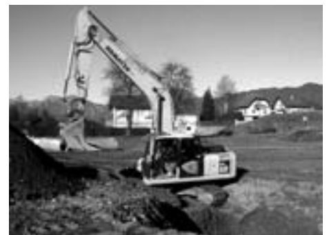
Grabarbeiten Tagwasserkanal Achomitz
