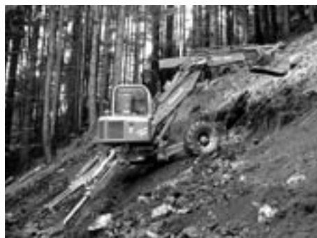
Sanierung Quellfassung
