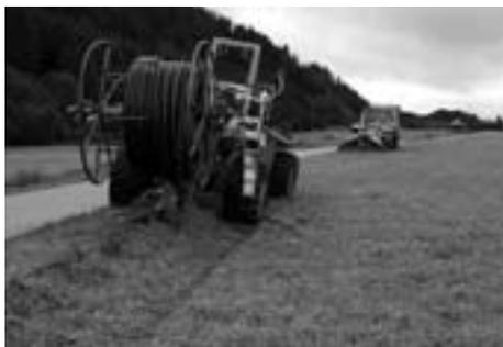
*Die Pumpdruckleitung von Achomitz bis Dreulach wurde mit modernster Technik - Pflugverfahren - eingebaut. In ca. 5 Stunden konnten ca. 500 lfm. Pumpdruckleitung auf wirtschaftliche Weise und kulturschonend eingebaut werden.*
