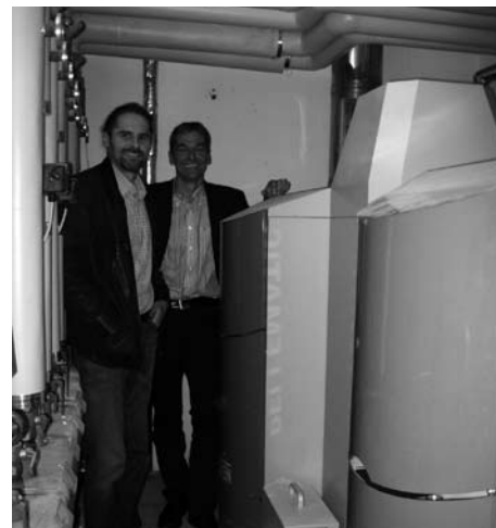
Ing. Rudolf Moschik und Bgm. Ing. Florian Tschinderle bei der neuen Heizungsanlage
