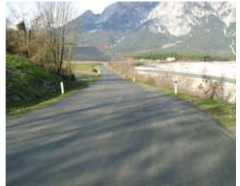
Die neue moderne Industriestraße
