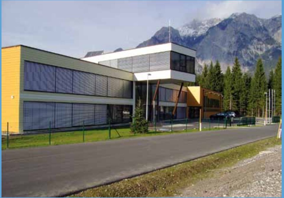
Das seit Herbst fertiggestellte Bürogebäude der Fa. Kraftool
