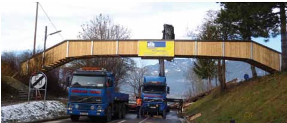
Mit schwerem Gerät wurde die alte Brücke aus den Anker gehoben
